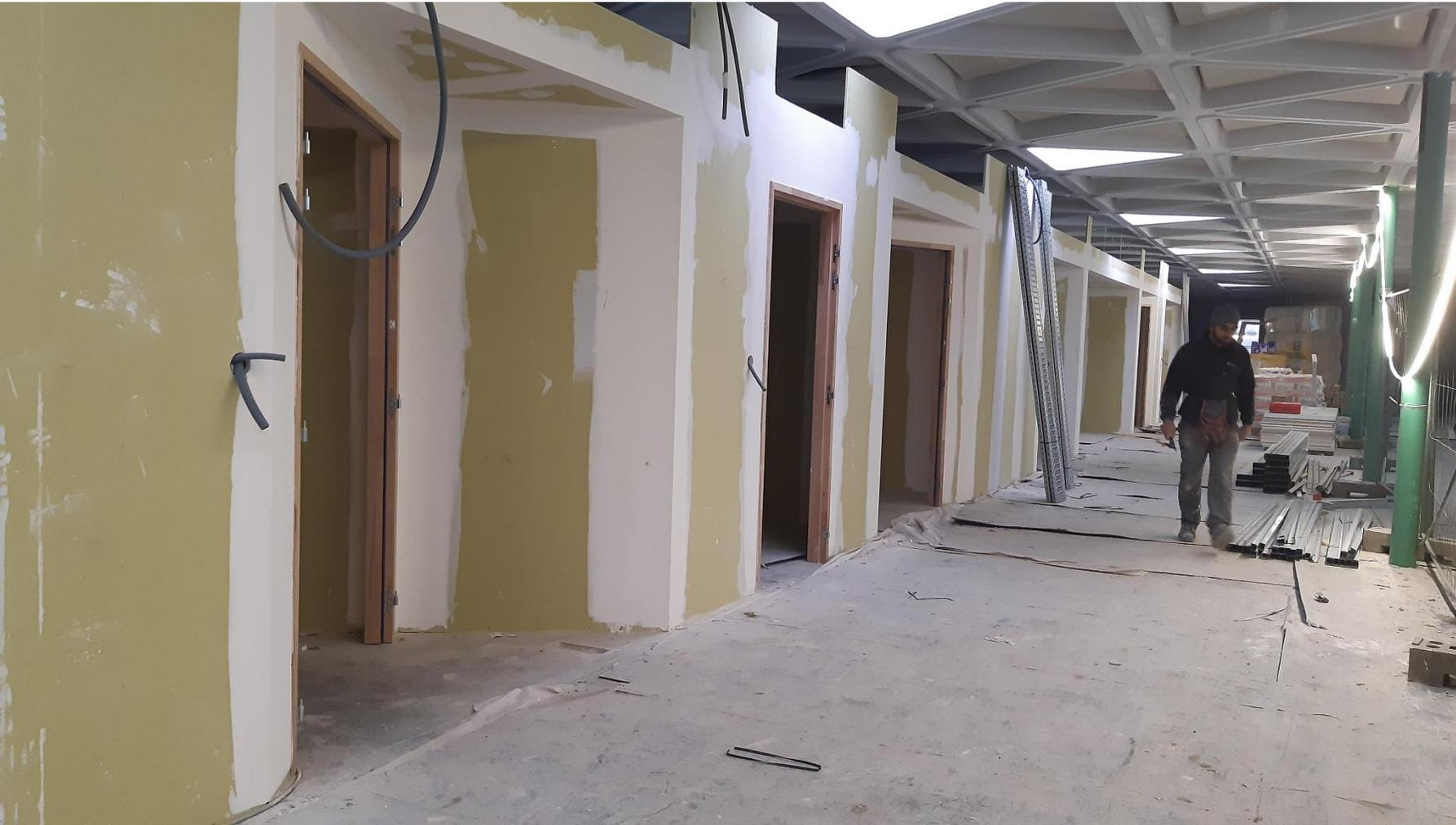
Cloisonnement des sas d'entrée dans les amphis et des locaux techniques entre les amphis et la galerie.
