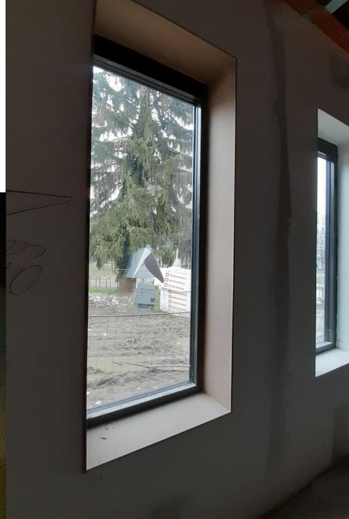
Doublage placo de la façade nord, pose des menuiseries et habillage bois des tableaux de fenêtres.
