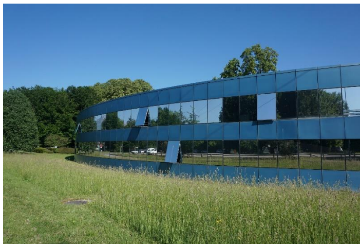
Photo 3 : Baies vitrées réfléchissantes ©A. Aubry
