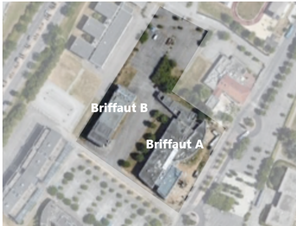
Vue aérienne des deux bâtiments Briffaut A et B
