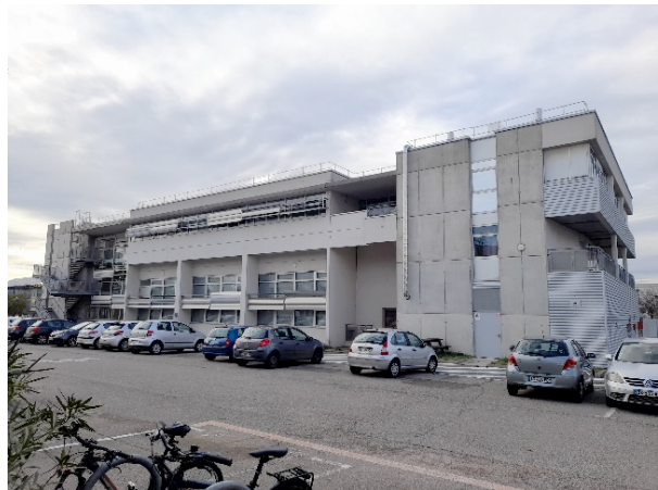
Vue du bâtiment Briffaut B depuis le parking
