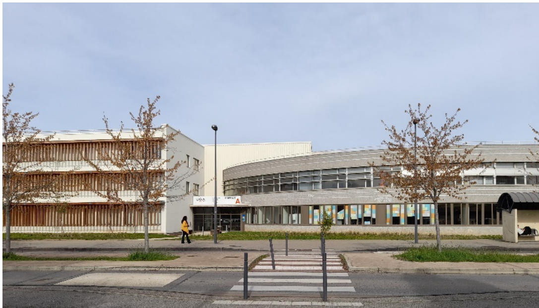
Vue du bâtiment Briffaut A (et son extension à gauche) depuis la rue Barthélemy de Laffemas
