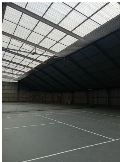
Intérieur de la halle
