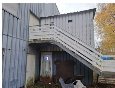
Vue de l'entrée logistique
