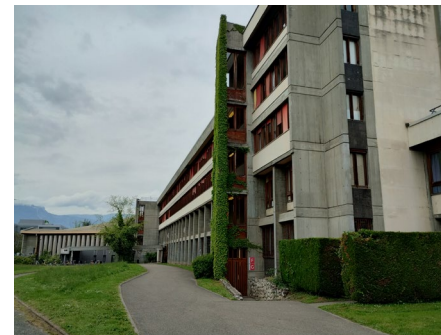
Pignon en béton armé
