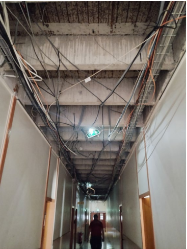
Reprise installation électrique bat I
