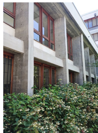
Structure poteaux poutres
