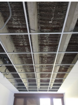
Préparation Faux plafond
