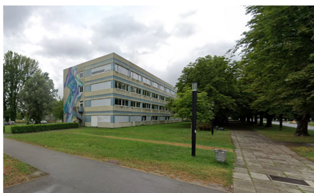
Photo bâtiment B
